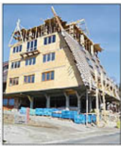
Trudno nie zauważyć „irregulację” budowy na Tatrzańskiej.
