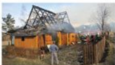
23.04.2010. Pożar starej chałupy na Antałówce. Dziś jest tu fragment wstrzymanej budowy syna ówczesnego burmistrza Janusza Majchra.
