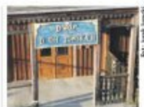
Zabytkowe wille w Osadzie Turystycznej Czorsztyn niszczą.
