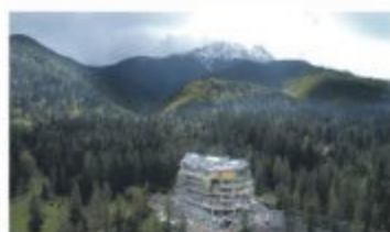
Druga do Białego. To najładniejsza szalowana budowa w Zakopanem i w Tatrach.
