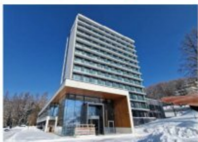
Dawne sanatorium Hotelik w Szczawnicy, dziś luksusowy hotel.
