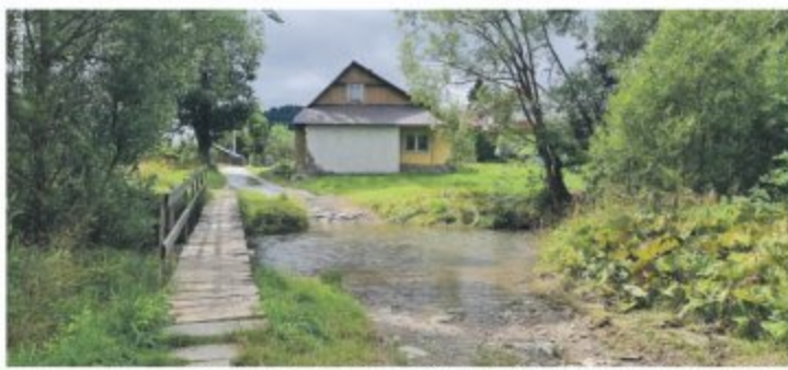
Dom dziecka Mikołaja jest tuż nad potokiem, nie ma ogrodzenia, w dodatku drzwi były uszkodzone i nie można było ich otworzyć.
