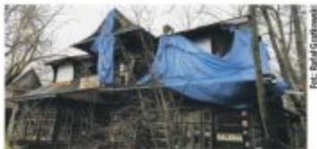
Hańbę przyspinał foliowe zabezpieczenia, dach trzeba przykryć solidną konstrukcją tymczasową z blachy trapezowej.
