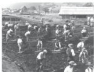
Rok 1925. Budowa zakopianki. Fot.: z arch. GDDKiA
